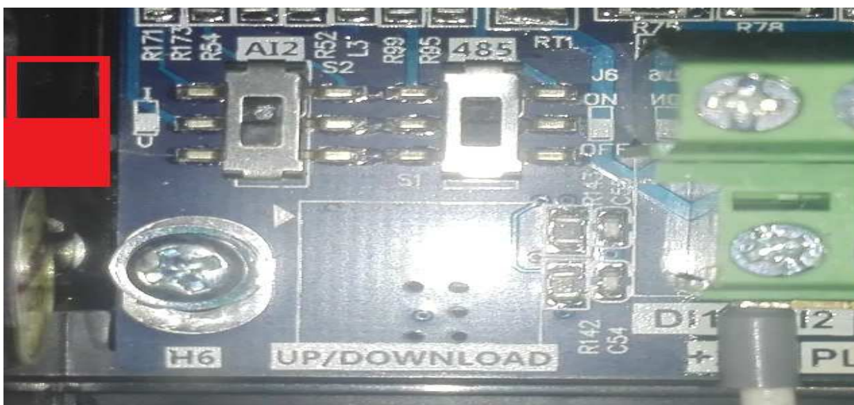
Рис.2 Положение переключателя AI2 в заводской настройке.
